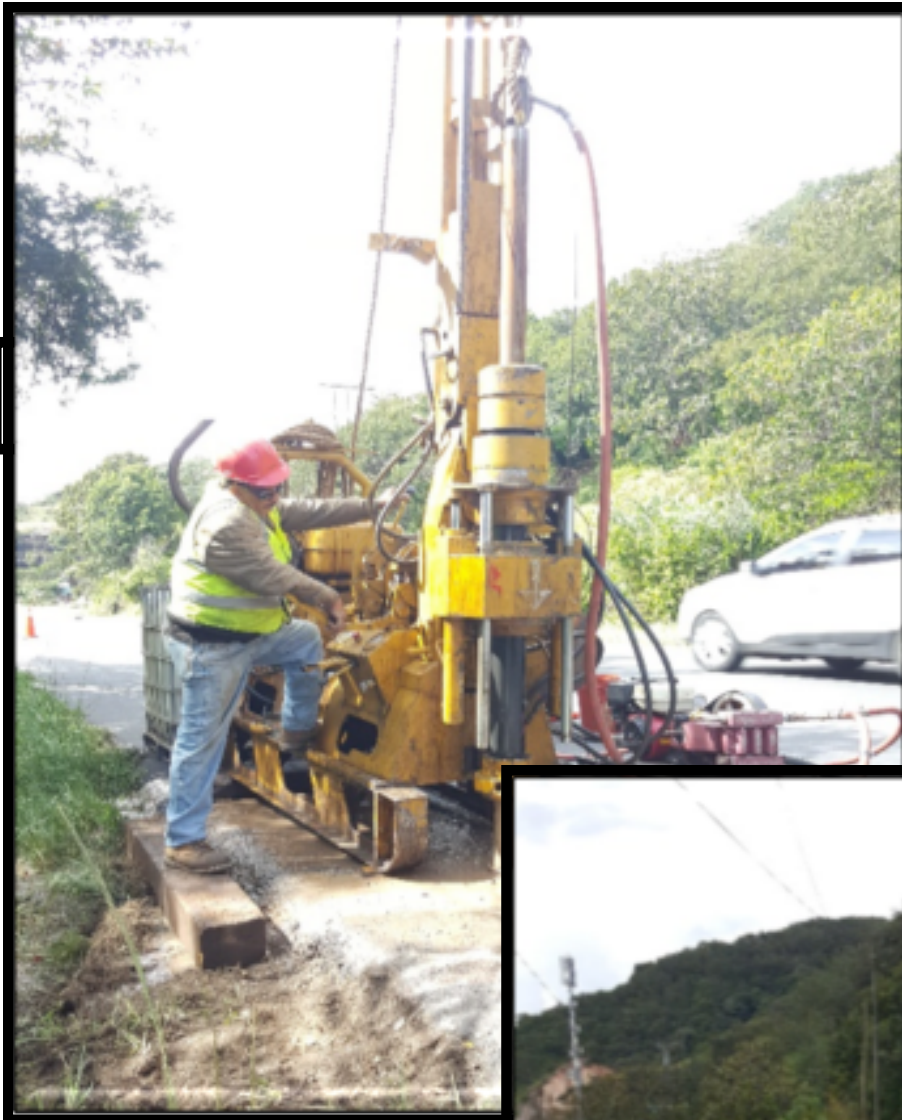
Ensayo SPT KM 18 A
